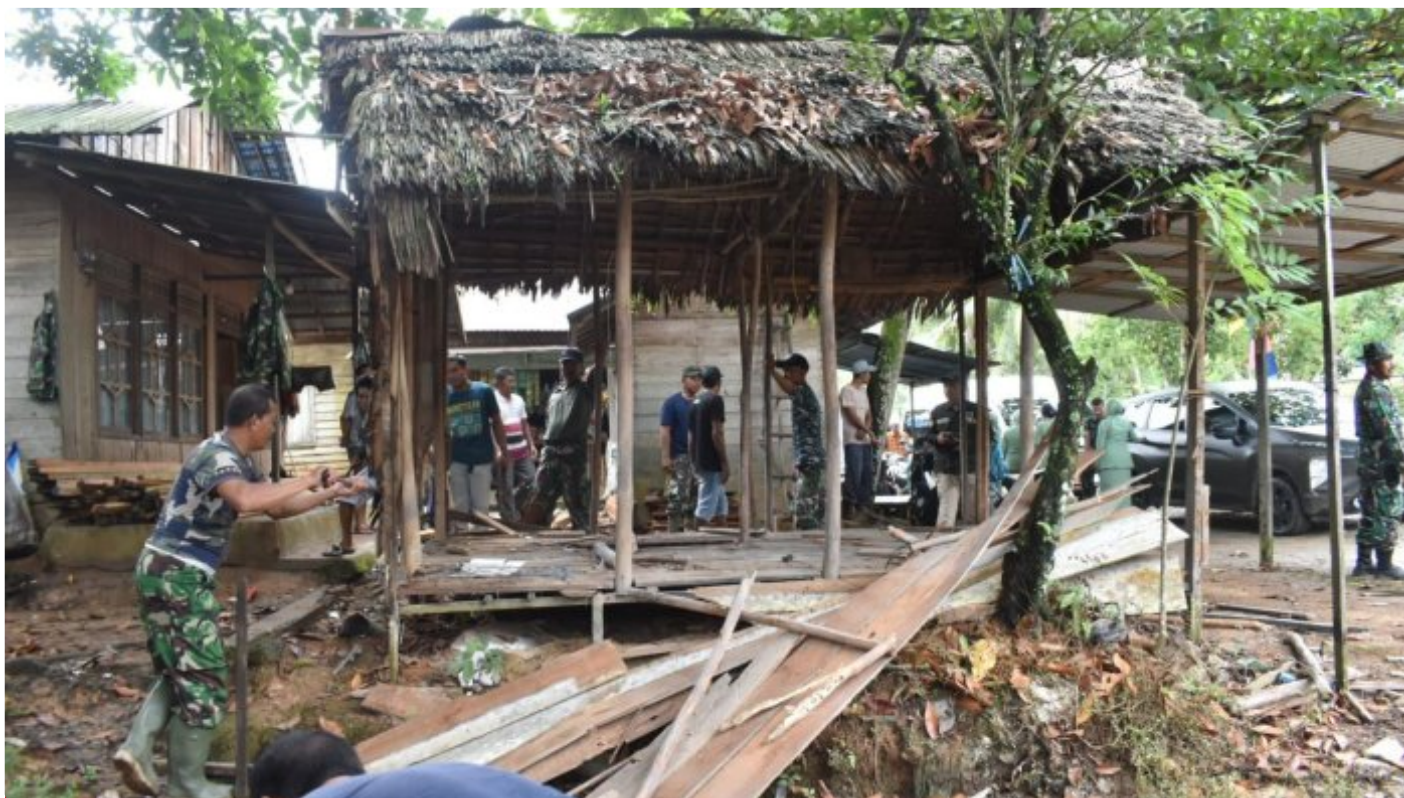
Anggota TNI Bongkar Rumah Warga Di Lokasi TMMD ke-116 Kodim 1002/HST
