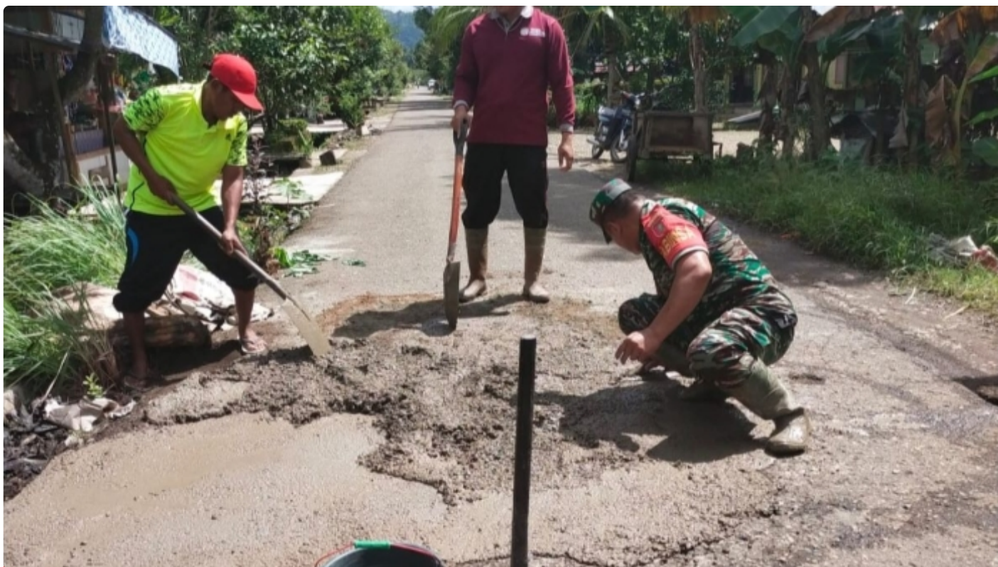
Babinsa Koramil 03/Haruyan Serda Yunus Suyanto bersama Aparat Desa Tabat Padang Perbaiki Jalan Rusak
