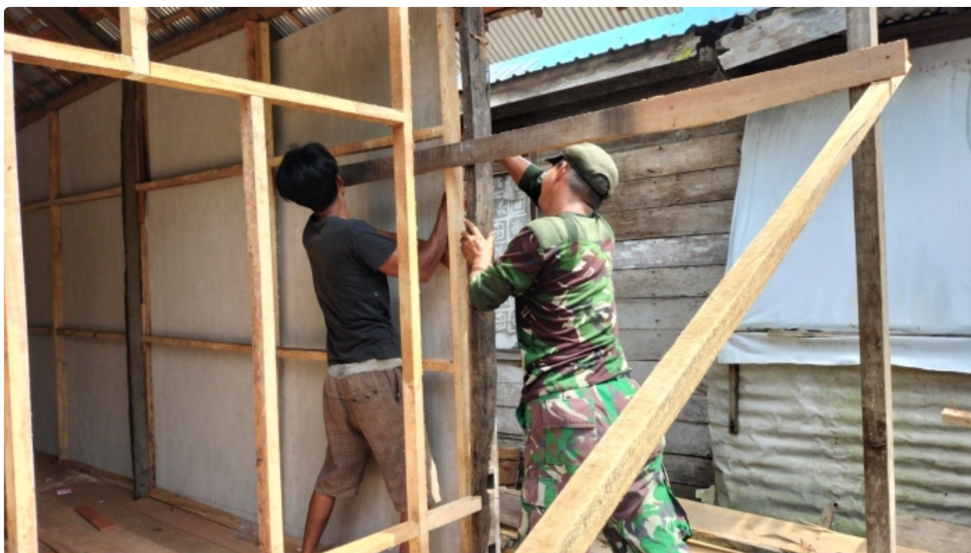
Pemasangan Dinding Rehab RTLH, Kodim 1002/HST
