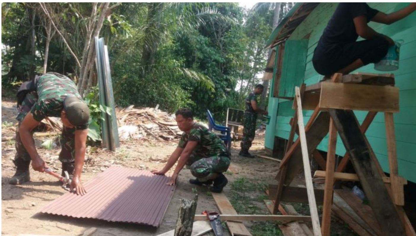
Gerak Cepat, Kodim 1002/HST Rehab Rumah M. Yusuf Capai 80 Persen
