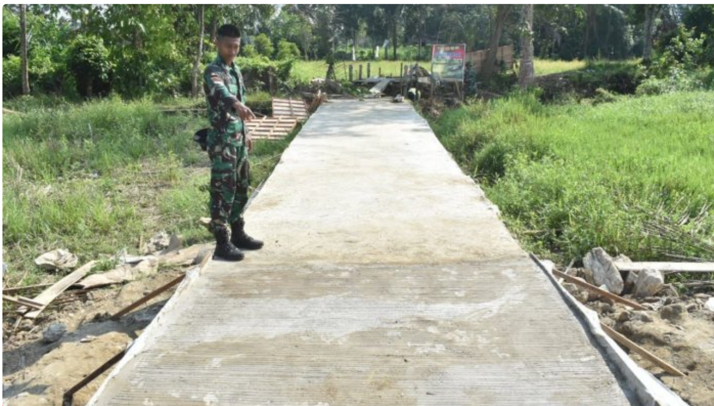
Gorong-gorong dan Slop Beton Rampung Seratus Persen
