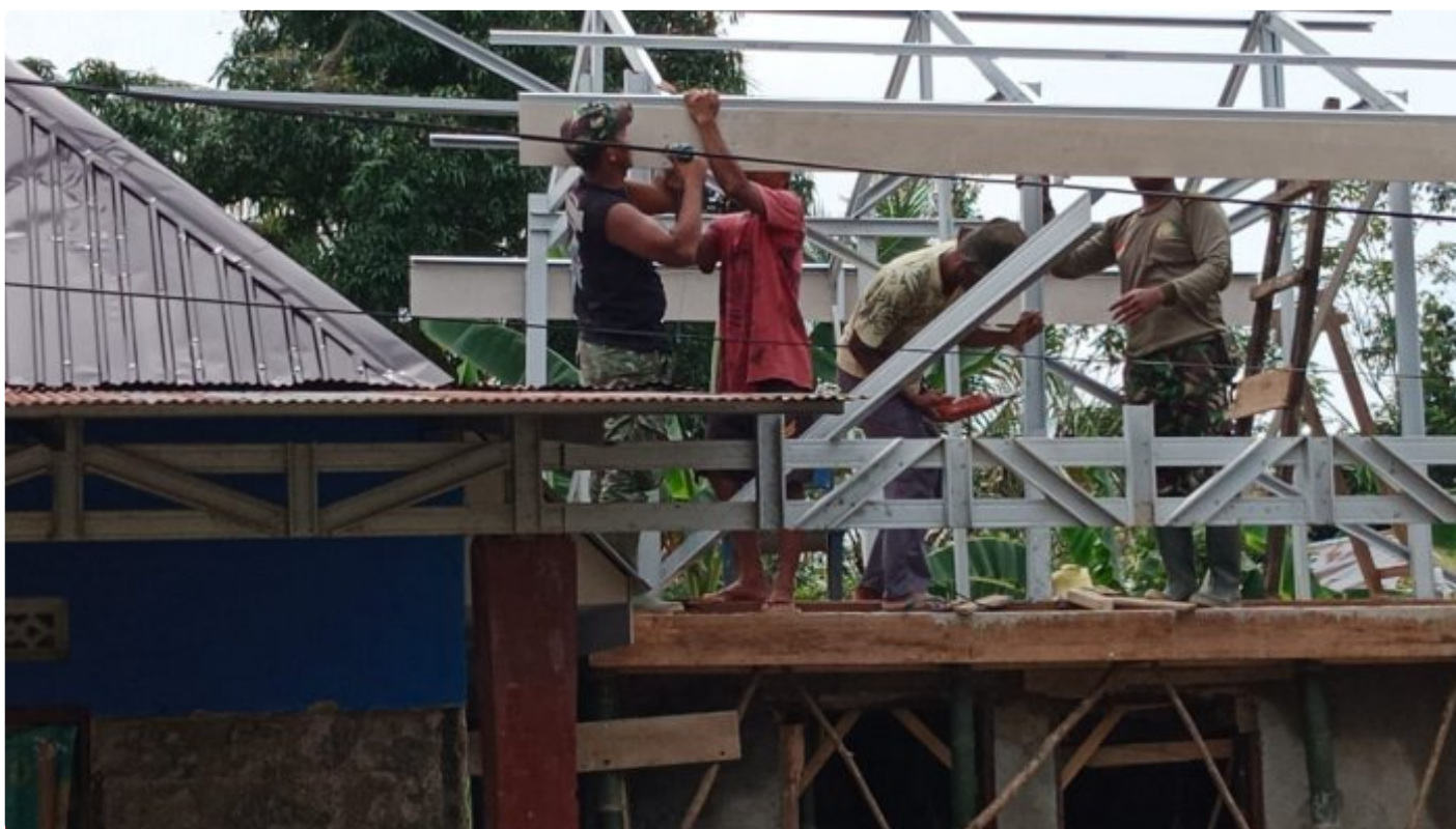
Pemasangan Rangka Atap Teras dan Mushola Darul Iman
