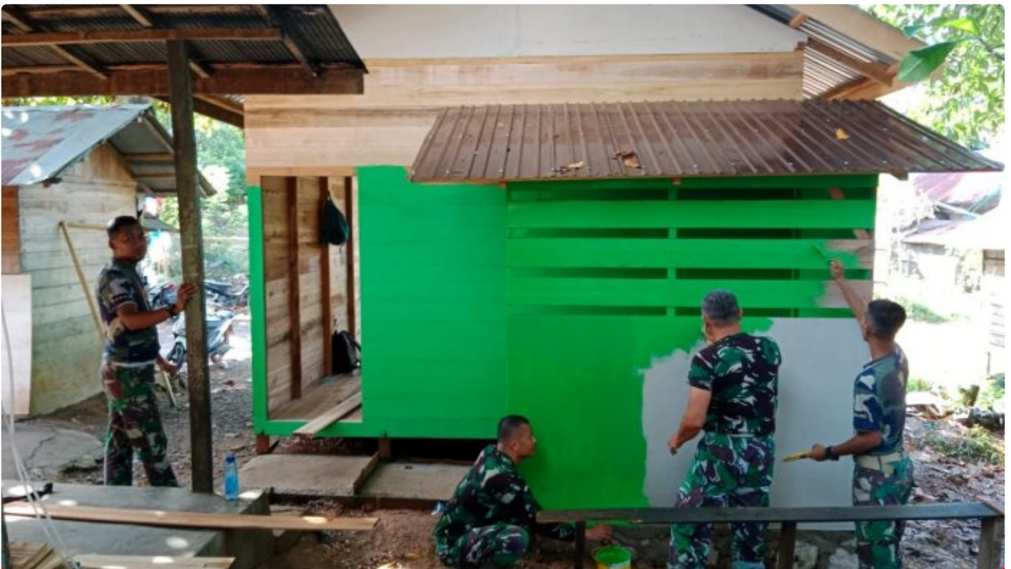
Rehab RTLH TMMD ke-116 Kodim 1002/HST Masuk Tahap Pengecetan
