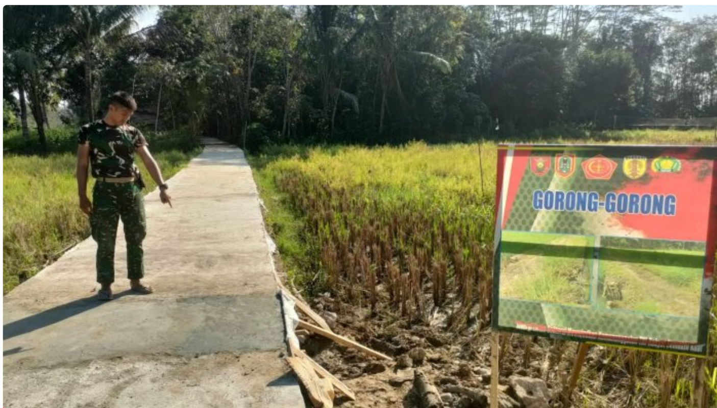
Sasaran Fisik Gorong-gorong 1 TMMD Ke-116 Kodim 1002/HST Rampung 100 Persen
