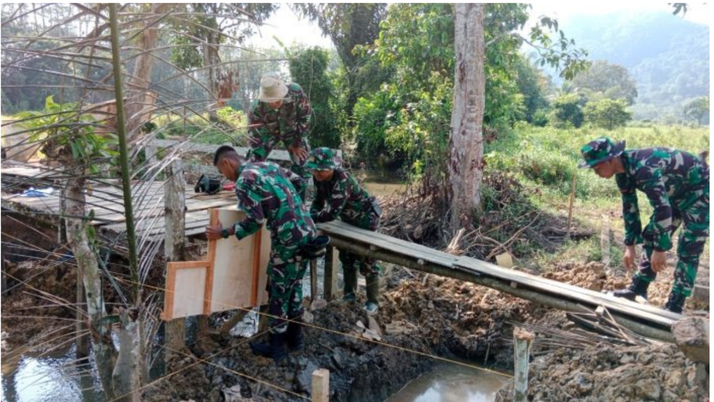
Satgas TMMMD ke-116 Kodim 1002/HST Dikerjakan Jembatan
