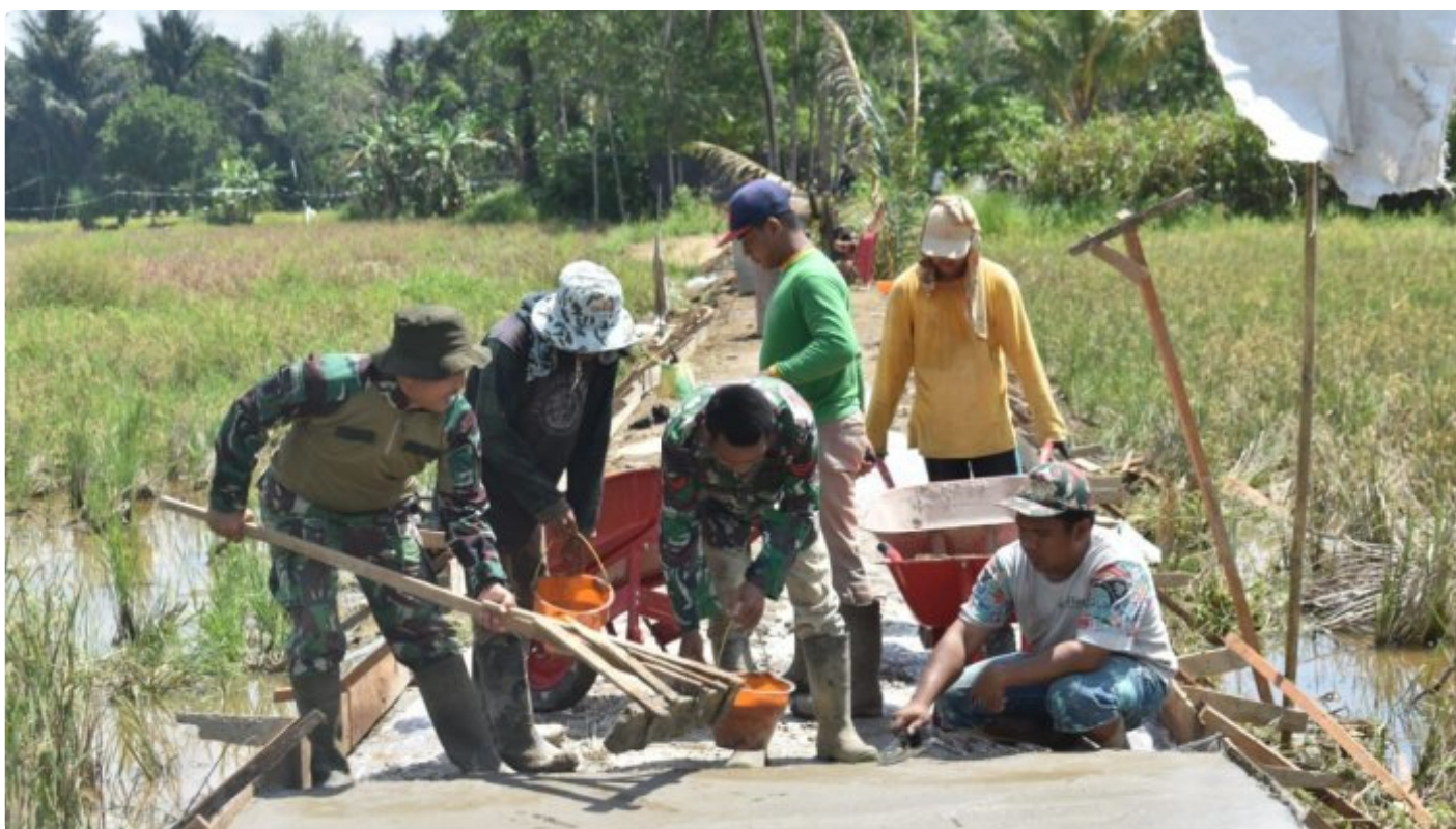
Satgas TMMD ke-116 Kodim 1002/HST Tetap Semangat Bekerja Meski Dibawah Terik Matahari
