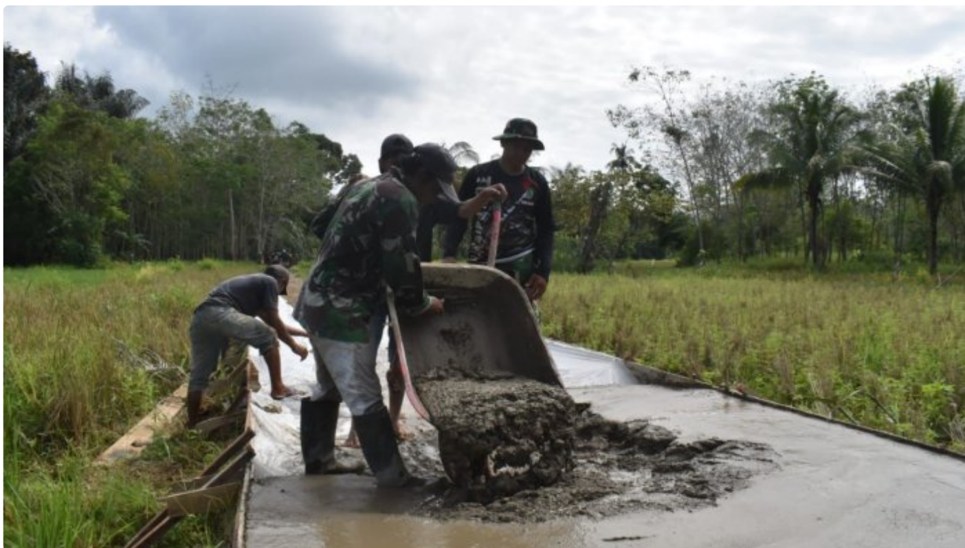
TMMD ke-116 Kodim 1002/HST Terus Genjot Pengerjaan Jalan
