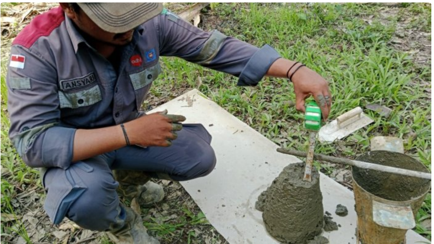
Uji Slump Beton Sasaran Jalan TMMD ke-116 Kodim 1002/HST Oleh Dinas PU dan Konsultan
